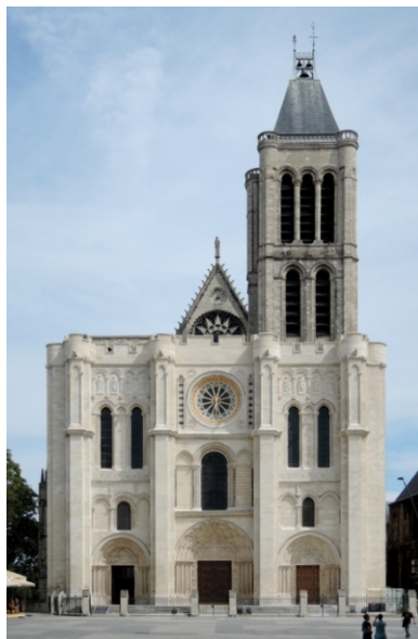
Fig.2. Fațada de vest a bisericii abațiale Saint-Denis
